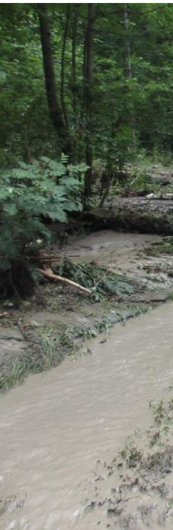
Schangnau BE, 2014 (© BVE, Tiefbauamt Bern)
