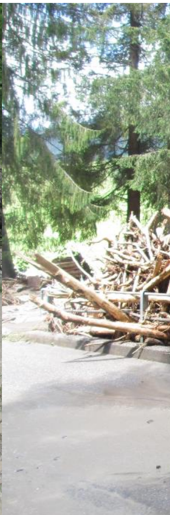
Schangnau BE, 2014 (© BVE, Tiefbauamt Bern)
