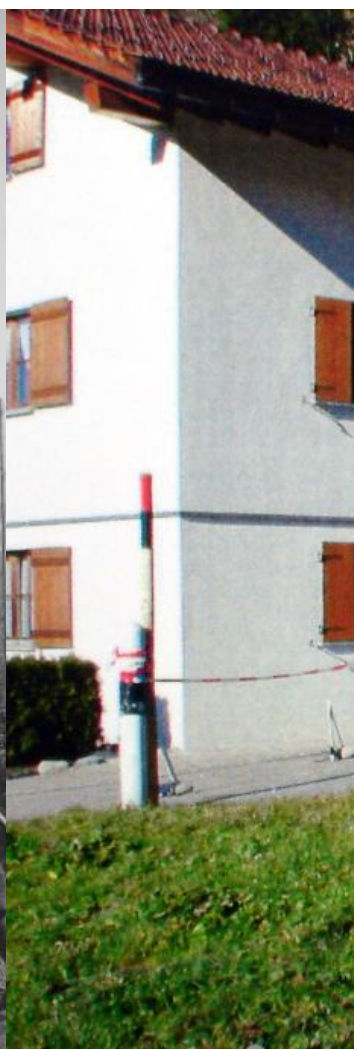
Rueun GR, 2002 (© Tiefbauamt Graubünden)
